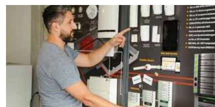
Ivo Simon erklärt seine Meldeanlagen: Störungen am System gehen auf seinem Handy ein und nötige Aktionen werden eingeleitet. Alarmmeldungen hingegen werden je nach Kundenwunsch auf Privatnummern oder auf Alarmempfangszentralen geschaltet.
